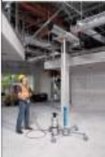
Existen sistemas portátiles y ligeros accionados mediante aire comprimido que permiten a un solo trabajador elevar cargas pesadas en cualquier lugar. Algunos sistemas son lo suficientemente compactos para ser transportados en el maletero de la mayoría de
