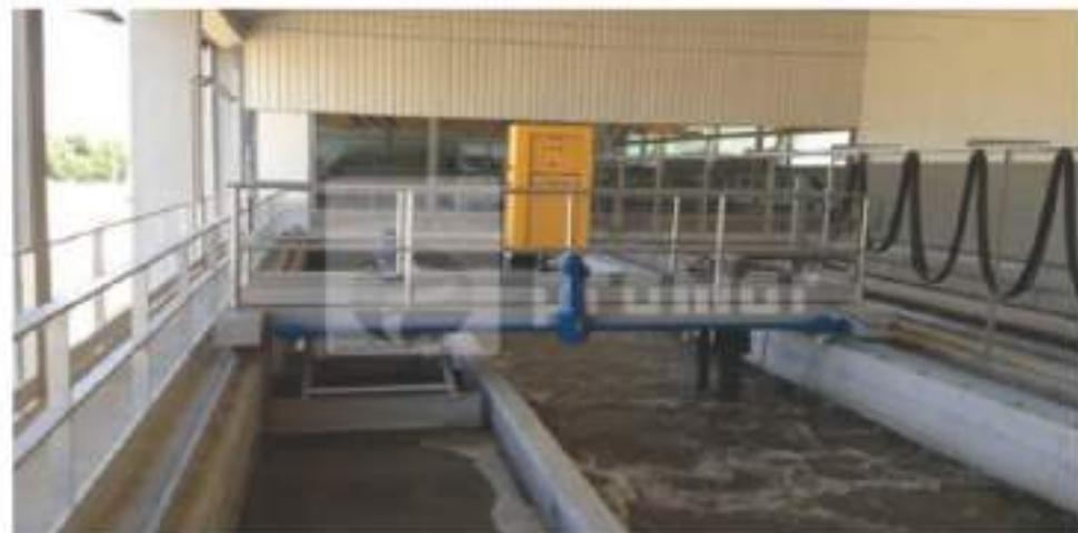
Este proceso se hace mediante bombas de soplado que generan una gran cantidad de aire, de forma que se agita el agua para que posteriormente decanten los sólidos más pequeños.
