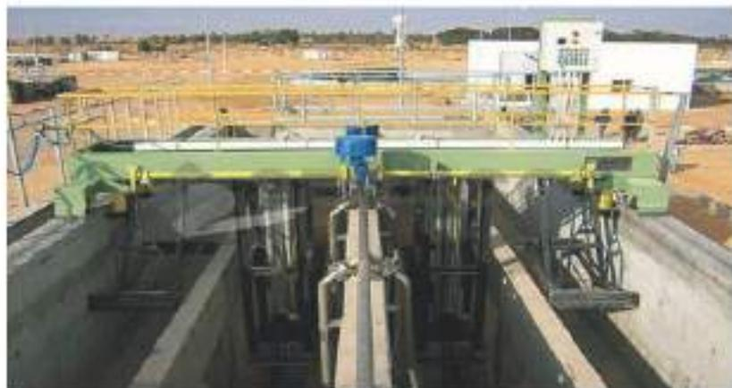
En esta etapa los flocúlos formados por la acción de los agentes coagulantes y floculantes sedimentan en tanques de forma circular o rectangular, obteniéndose por la parte superior el agua clarificada y extrayéndose por el fondo una corriente de lodos que contienen los flocúlos sólidos.
