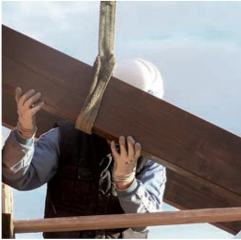
👍 | Utilizar casco de protección para la cabeza, como equipo de protección individual certificado
